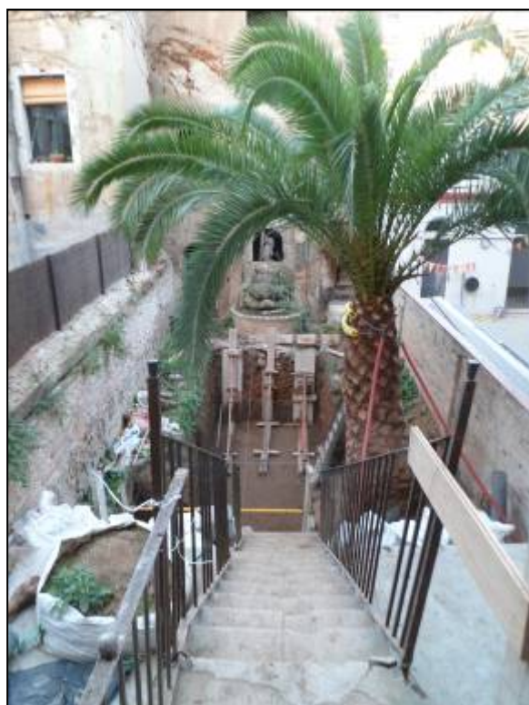
Fig.1. Estat de la piscina abans i després de les mesures correctores
